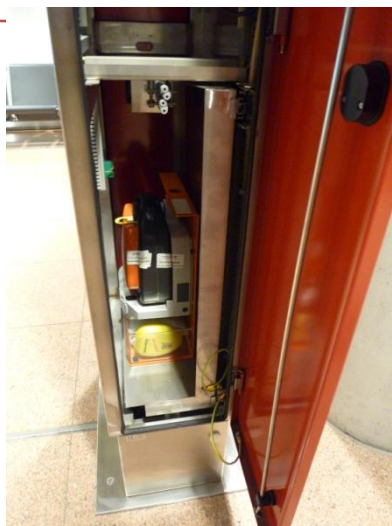
Geöffnete Lade mit Defibrillatoreinheit
