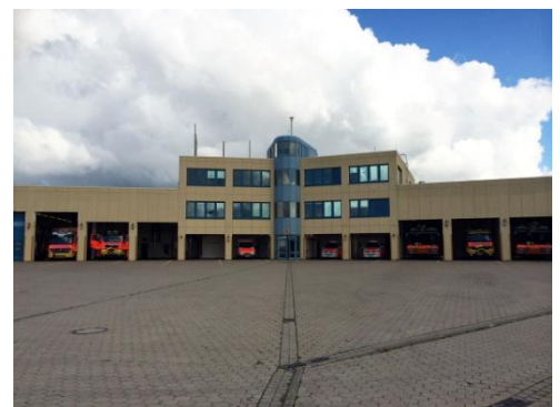
Gebäude der Flughafenfeuerwehr
