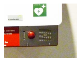
Notrufbox mit Defibrillator und Sprechstelle
